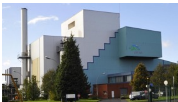
UNITÉ DE VALORISATION ÉNERGÉTIQUE DE MAUBEUGE - SMIAA
