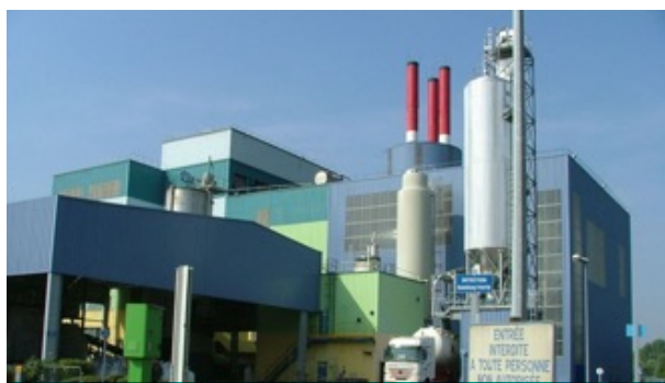
UNITÉ DE VALORISATION ÉNERGÉTIQUE DE SAINT-SAULVE - ECOVALOR
